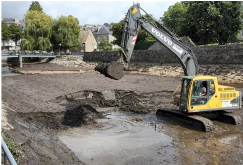
Figure 52 - Ecluse de Vire, curage à sec (Ouest France)
