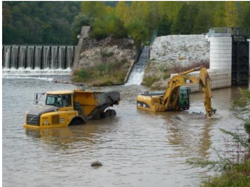
Figure 53 - Ecluse de Marsenac, curage en eau (Commune de Flagnac)
